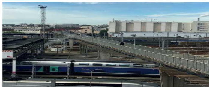
Vue générale de la passerelle
